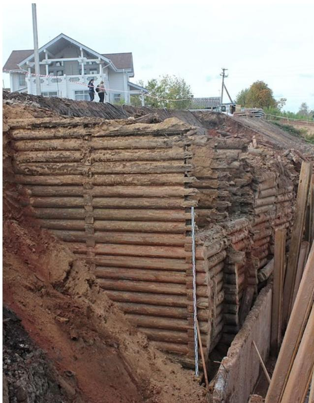
Рис. 5. Восточный фасад южной стены шлюзового канала. Вид с северо-востока
