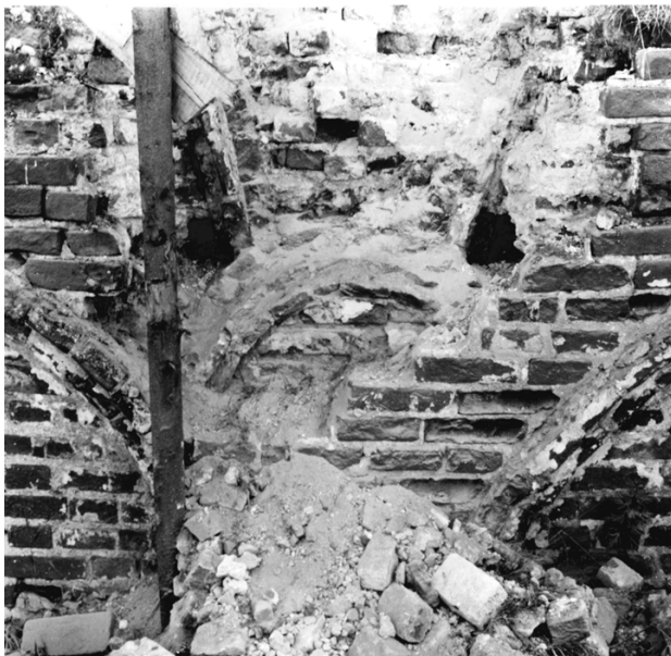
Рис. 5. Общий вид кокошников перехода с четверика на восьмерик в процессе раскрытия. Фото В.А. Шабаршина. 1989 г.
