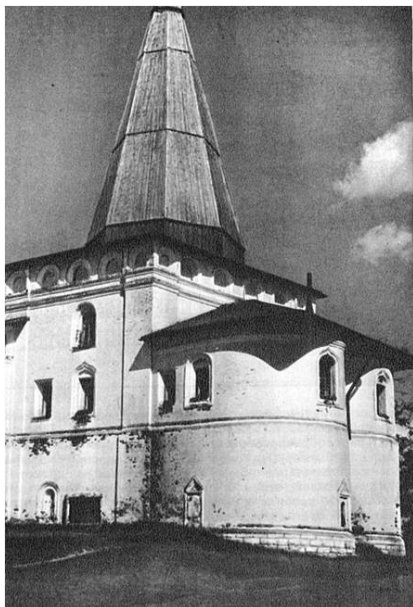
Рис. 3. Благовещенская церковь. Фотография С.С. Подъяпольского 1960-х годов из его книги «По Сухоне и Северной Двине»
